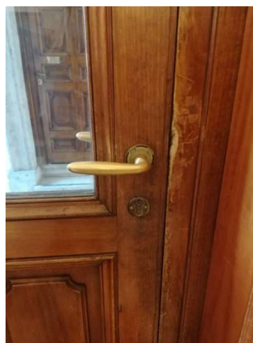
Fig. 1 – Palazzo Ossoli – infissi interni in legno degradato
