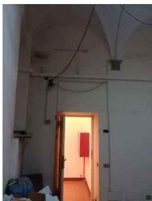
Foto n.28 – impianto elettrico fuori traccia piano terra Ambiente 2 e C5
