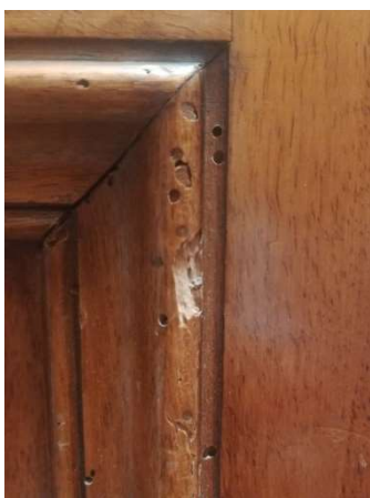
Fig. 1 – Palazzo Ossoli – infissi interni in legno degradato
